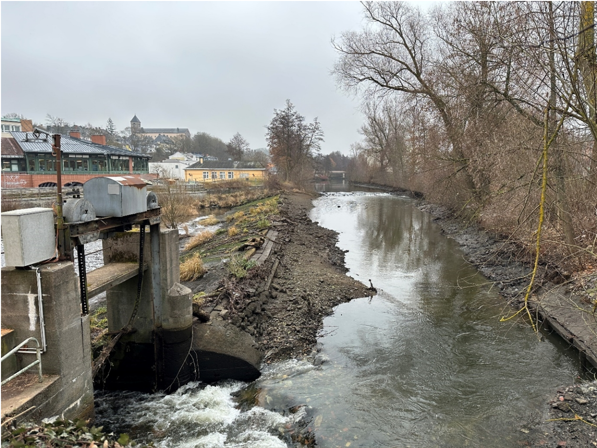
Bild (WWA Hof): Links das defekte Schützbauwerk; Saaleverlauf oberhalb des Hallenbadwehrs.
