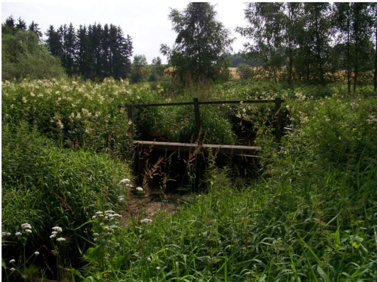
Abb. 2: Kleines Stauwehr an der südlichen Regnitz, welches zu veränderten Wasser- und Strukturverhältnissen führt
