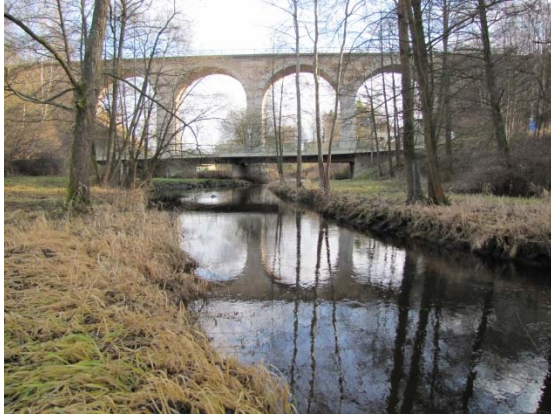
Abbildung 3: Ist-Situation 2016 im Ortsbereich Markt-leuthen: Linearer Gewässerlauf ohne Struktur (Foto: WWA Hof)
