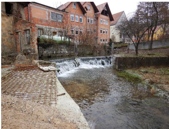
Abbildung 3: Ist-Situation an der Kainach Fkm 0,2. Nicht durchgängige Wehranlage in der Stadt Hollfeld.
