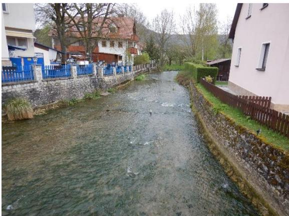
Abbildung 3: Ist-Situation am Leinleiterbach Fkm 1,2. Monotone und befestigte Uferlinie in Gasseldorf.
