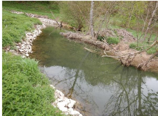
Abbildung 2: Ist-Situation am Leinleiterbach Fkm 9,1. Sich eintiefender Flusslauf mit Uferbefestigung.
