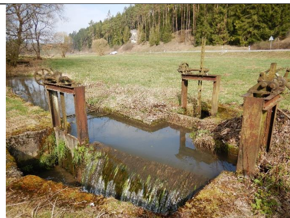
Abbildung 3: Ist-Situation an der Wiesent Fkm 75,5. Nicht durchgängige Wehre.
