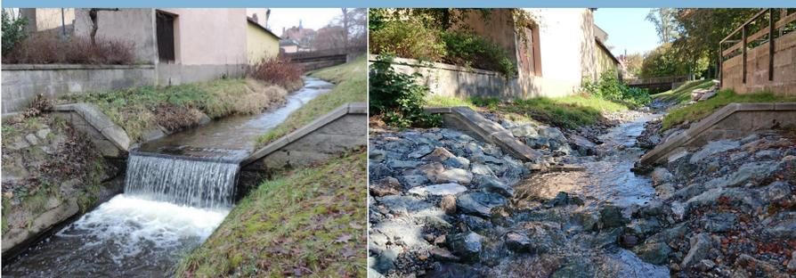
Mit einer „rauen Rampe“ wird an einem alten Absturz in der Stadtmitte die **Durchgängigkeit für Tiere** ermöglicht.
