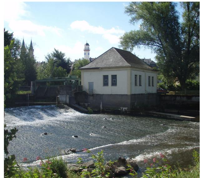
Wie funktioniert eine Fischschleuse? Einer kontinuierlichen Lockströmung folgend gelangen die Fische in die Schleuse (Einschwimphase), werden dort sanft gehoben und schwimmen in der Ausschwimphase wieder aus der Schleuse. Der Fischabstieg findet in einer separaten Rinne statt.
