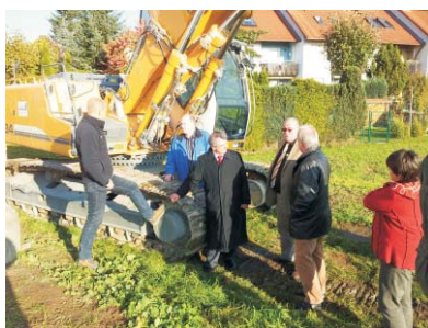
Erste Arbeiten und Presseinformation am 25. Oktober 2011
