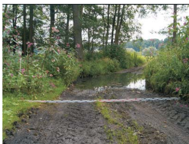
Zustand vor Baubeginn
