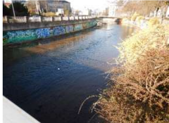
Abbildung 2: Ist-Situation Fkm 33,6. Monotone, befestigte Uferlinie und Sohle in Bayreuth.
