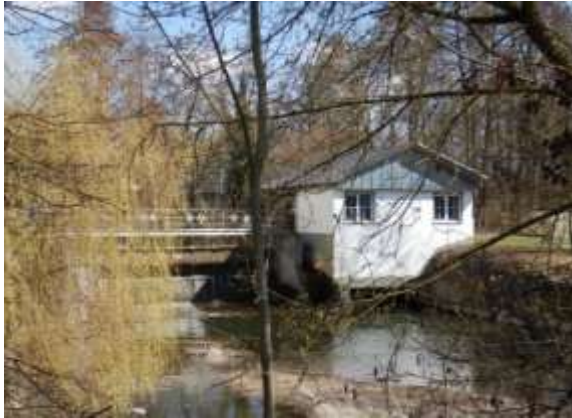
Abbildung 1: Ist-Situation in Bayreuth Fkm 36,6. Nicht durchgängige Wehranlage.
