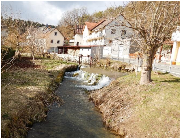
Abbildung 1: Ist-Situation an der Aufseß Fkm 8,4. Nicht durchgängige Wehranlage in der Gemeinde Draisendorf.
