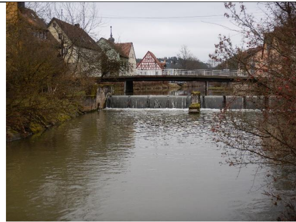
Abbildung 1: Ist-Situation an der Wiesent Fkm 45,8. Wehr nicht durchgängig in Waischenfeld.
