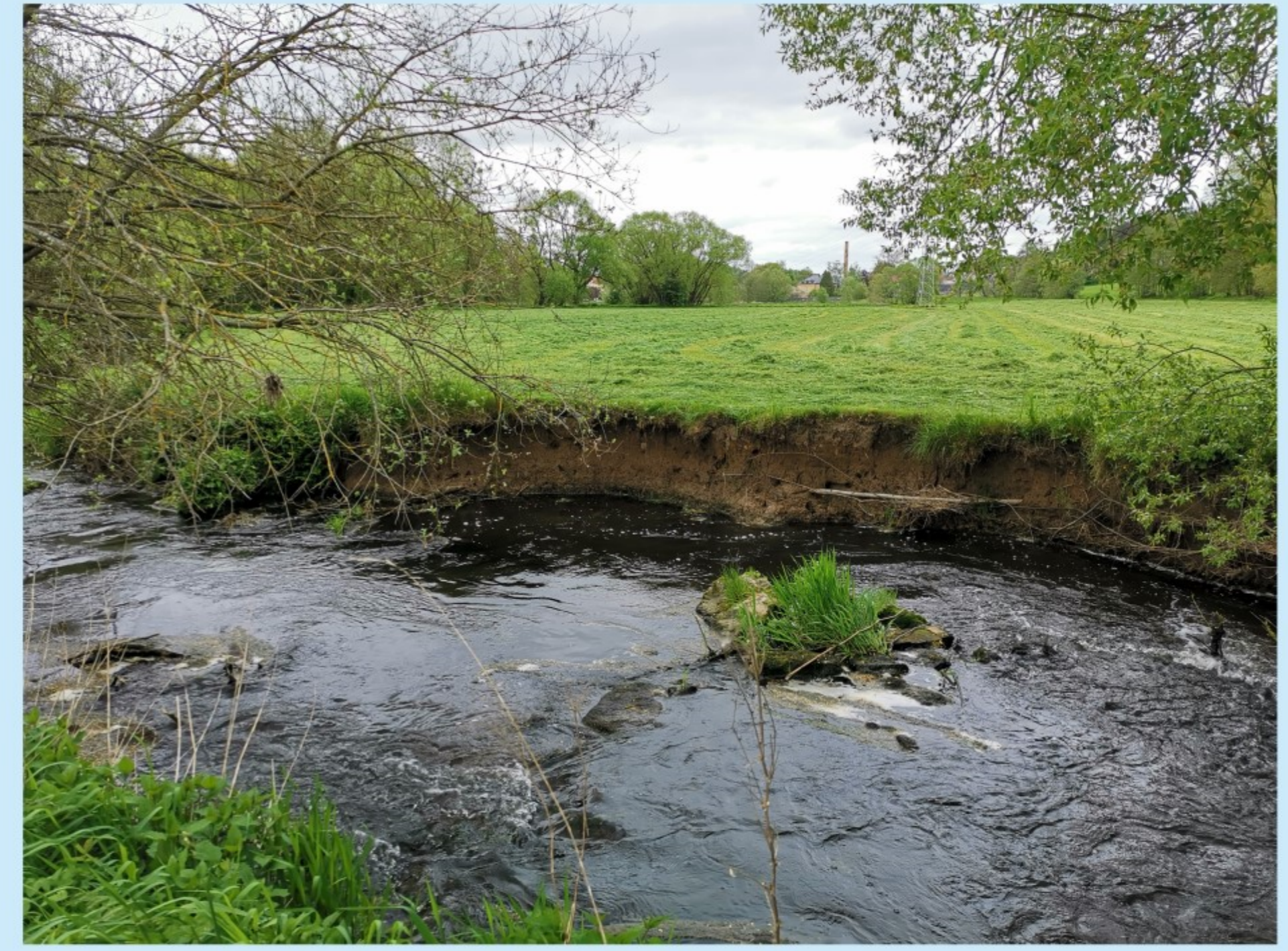
Blick auf Uferanbruch
