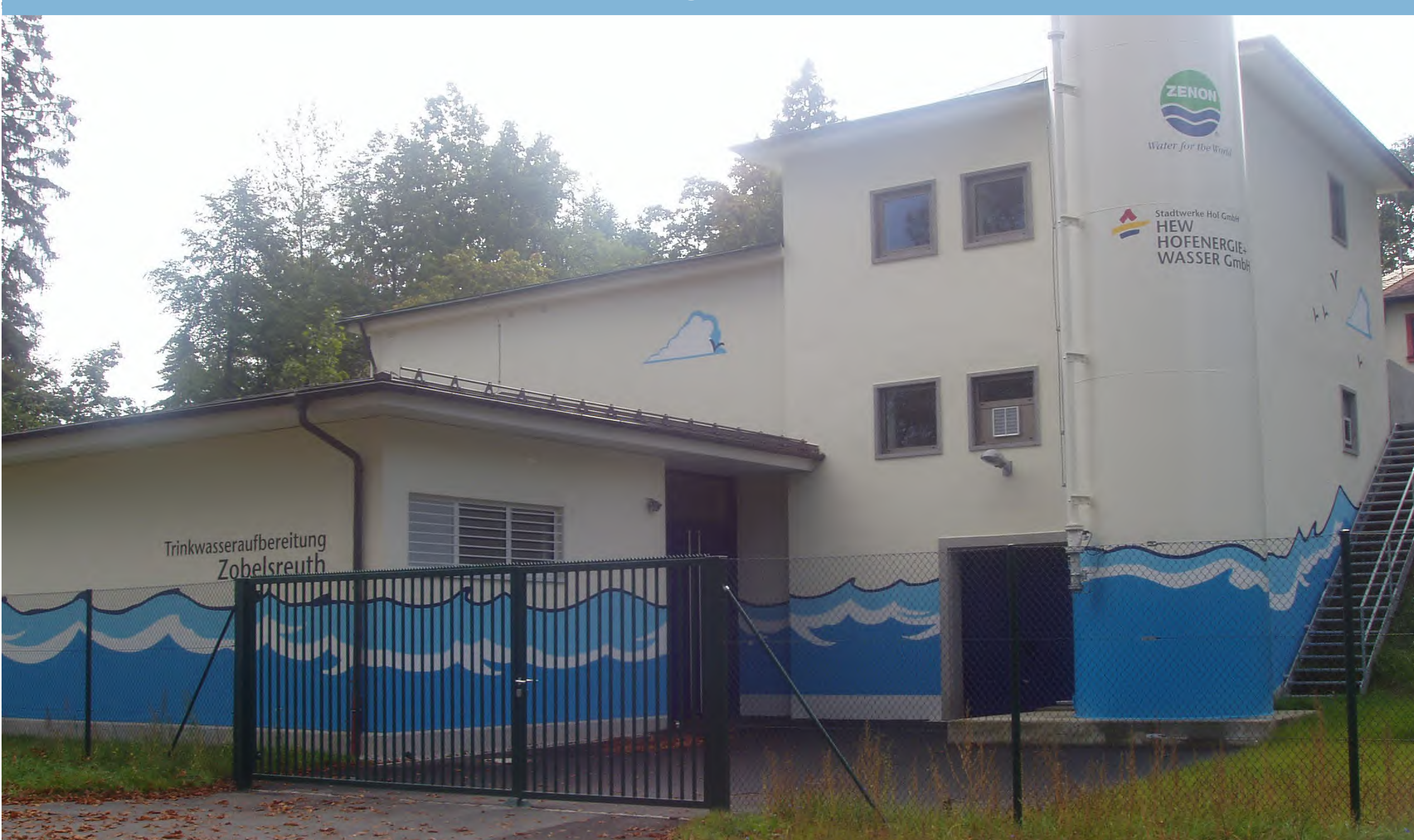
Quellwasser wird in der Trinkwasseraufbereitungsanlage Zohelsreuth (Stadt Hof) aufbereitet (Ultrafiltration, Entsäuerungsfiltration, Desinfektion). (Foto WWA Hof)
