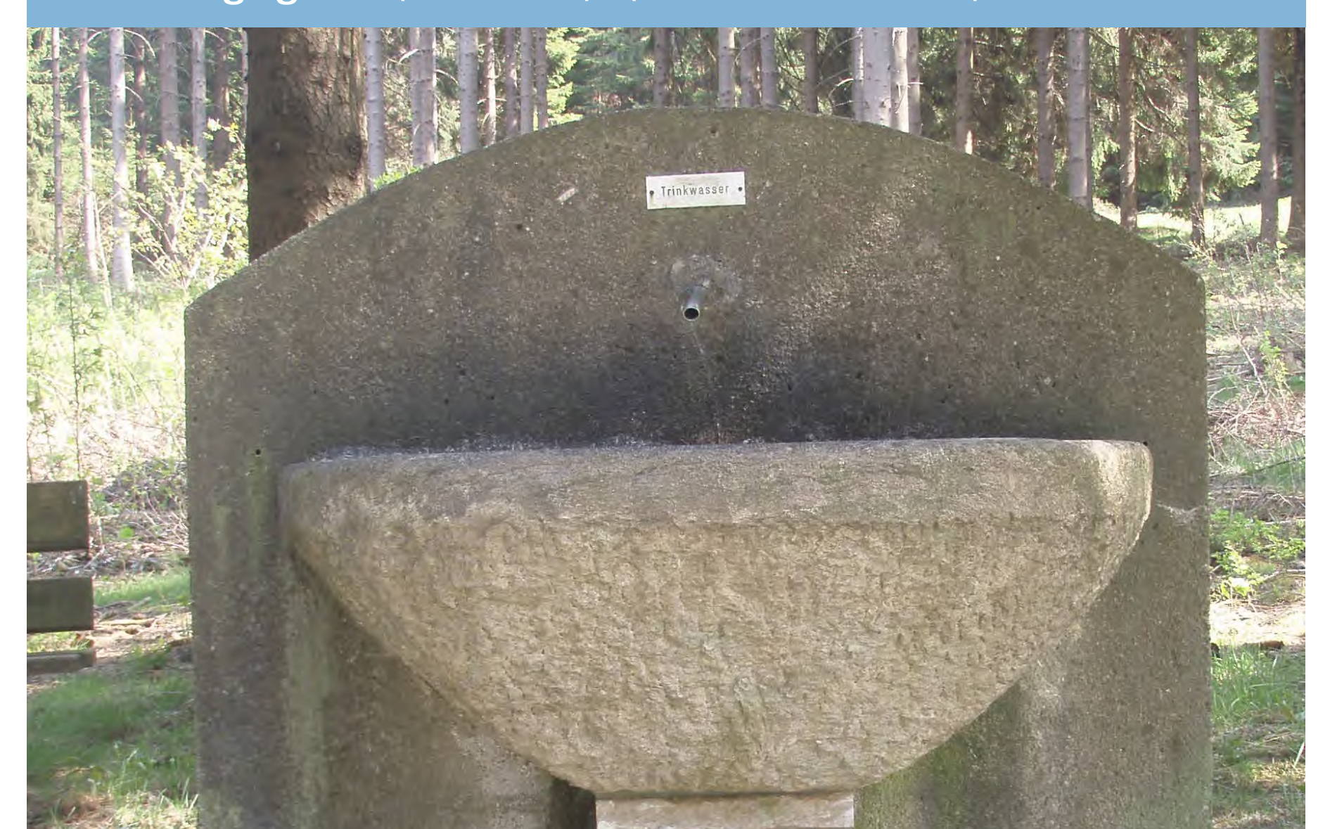
Ein Trinkwasserbrunnen, bzw. Laufbrunnen bei Hertweggrün (Lkr. Hof). (Foto WWA Hof)
