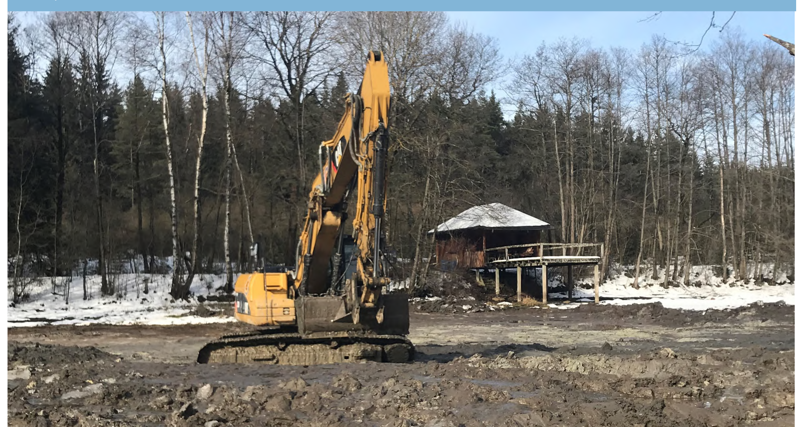
2021 - Bauarbeiten des WWA Hof an Teichen in der Nähe der Huschermühle zur Niedrigwasseraufbesserung für die Aufzucht der Flussperlmuschel. (Foto WWA Hof)
