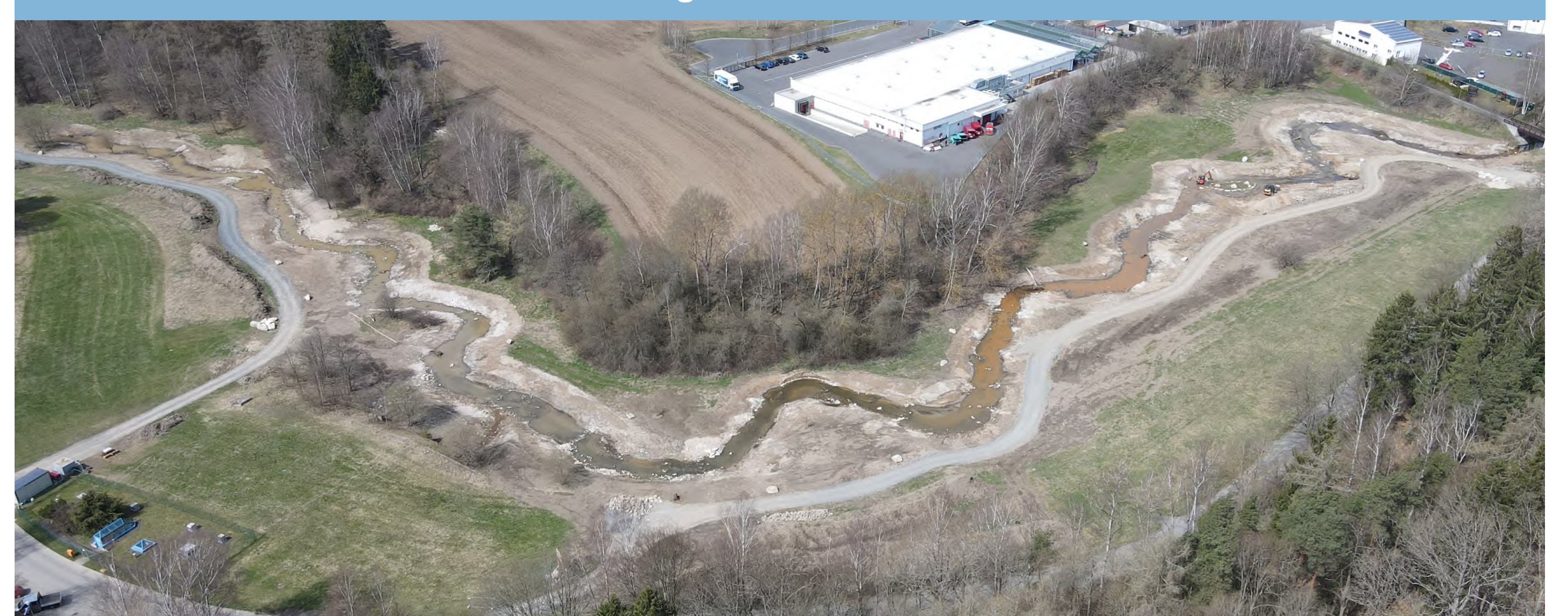
Die Selb während der Renaturierung. (Fotos WWA Hof)
