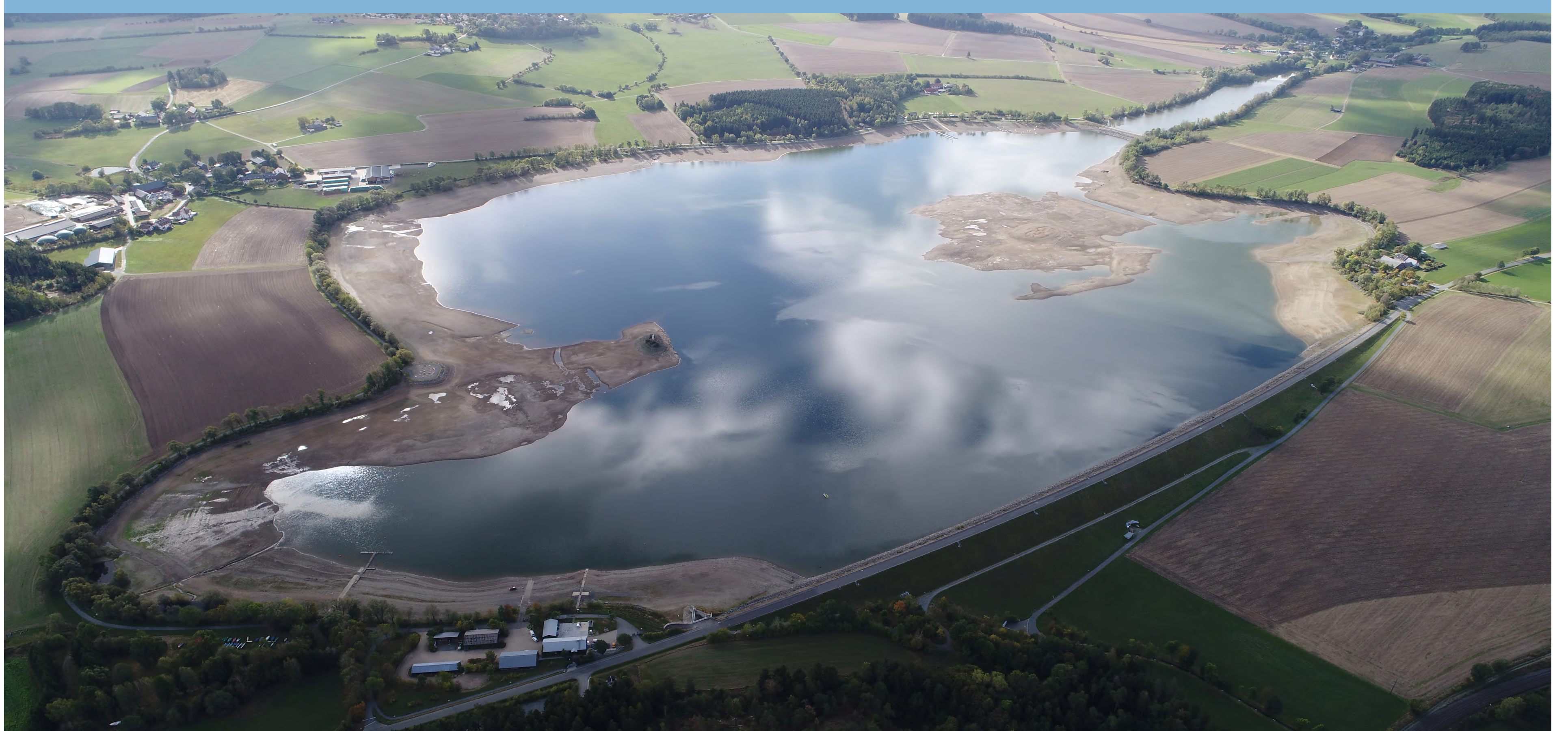
2018 - der beinahe leere Förmitzspeicher (Foto WWA Hof)
