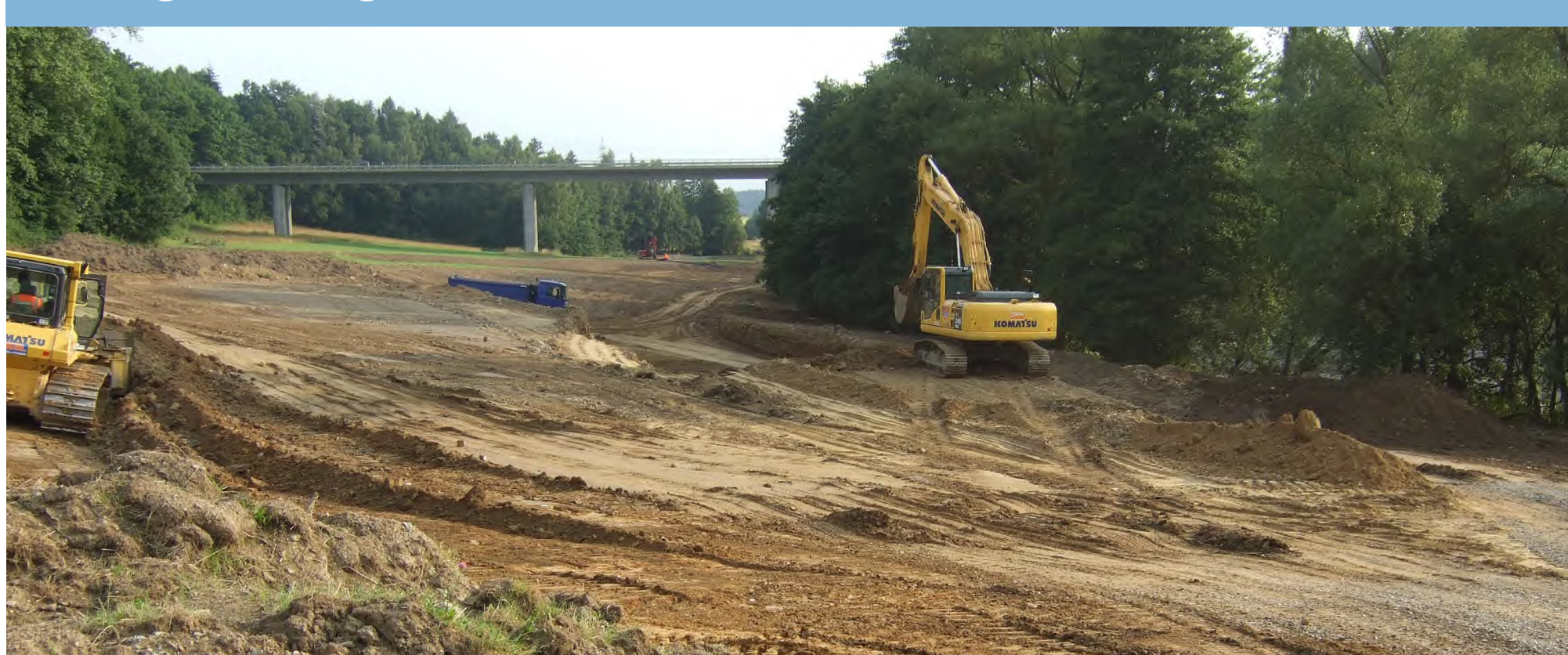
Natürlicher Rückhalt im Ökopark Hertelsleite bei Schwarzenbach an der Saale. 2008 beim Bau und 2009 nach der Fertigstellung (Fotos WWA Hof)
