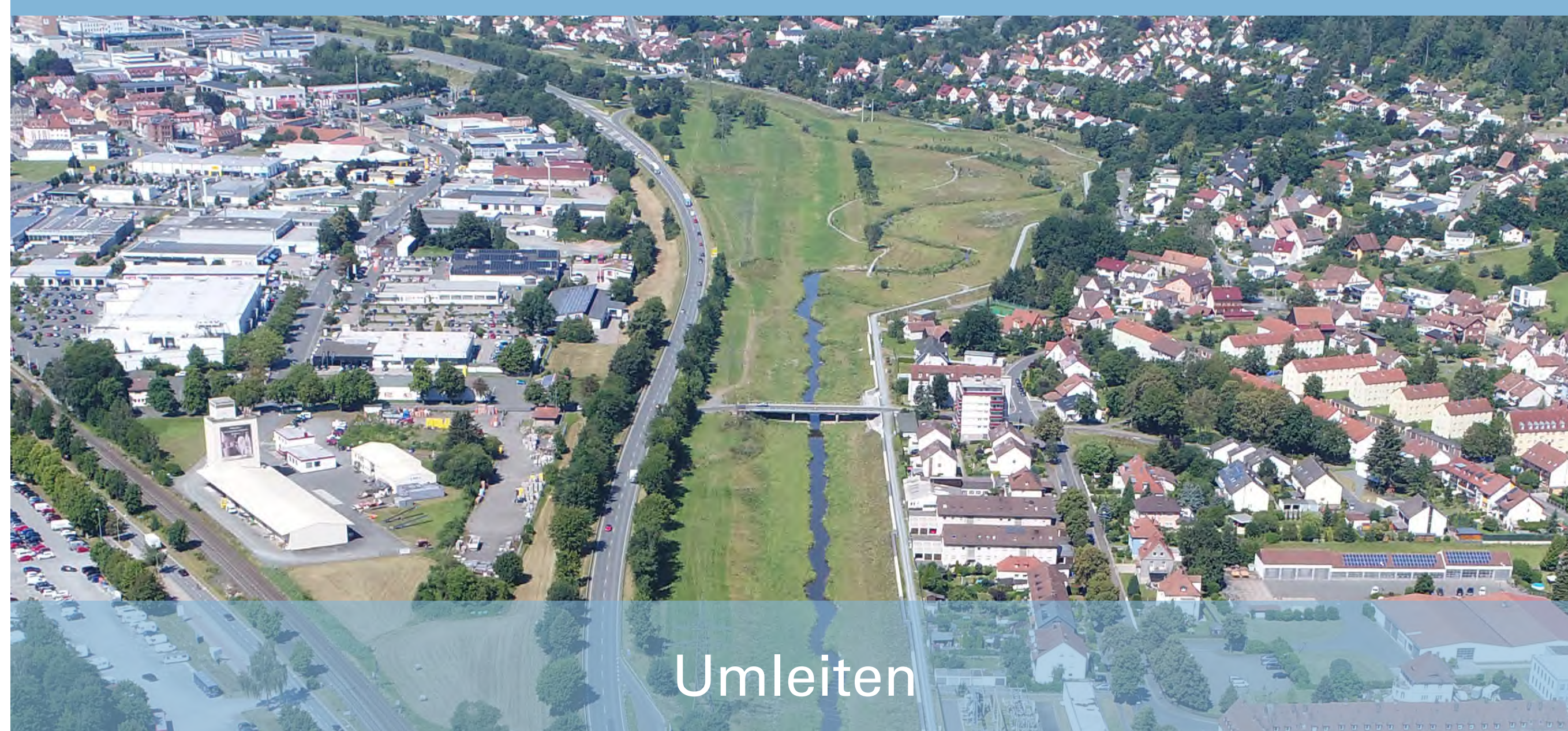
Gleich mehrere Hochwasserschutzmaßnahmen kommen heute in Kulmbach zum Einsatz. Allerdings wurde schon 1933 Hochwasser in die Flutmulde umgeleitet. (Foto WWA Hof)
