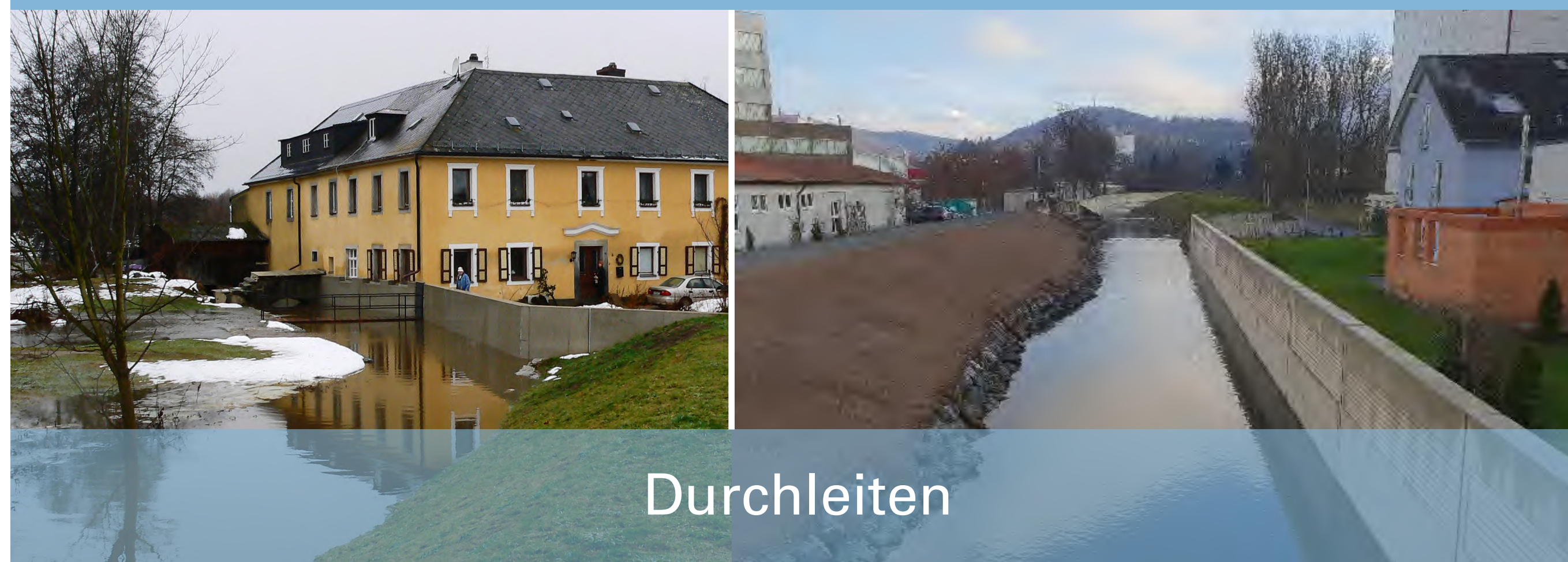
Deich und Mauer als technischer Hochwasserschutz leiten den Weißen Main in Kulmbach (rechts) und die Kössein bei Wölsau (Lkr. Wunsiedel) durch bebautes Gebiet. (Foto WWA Hof)
