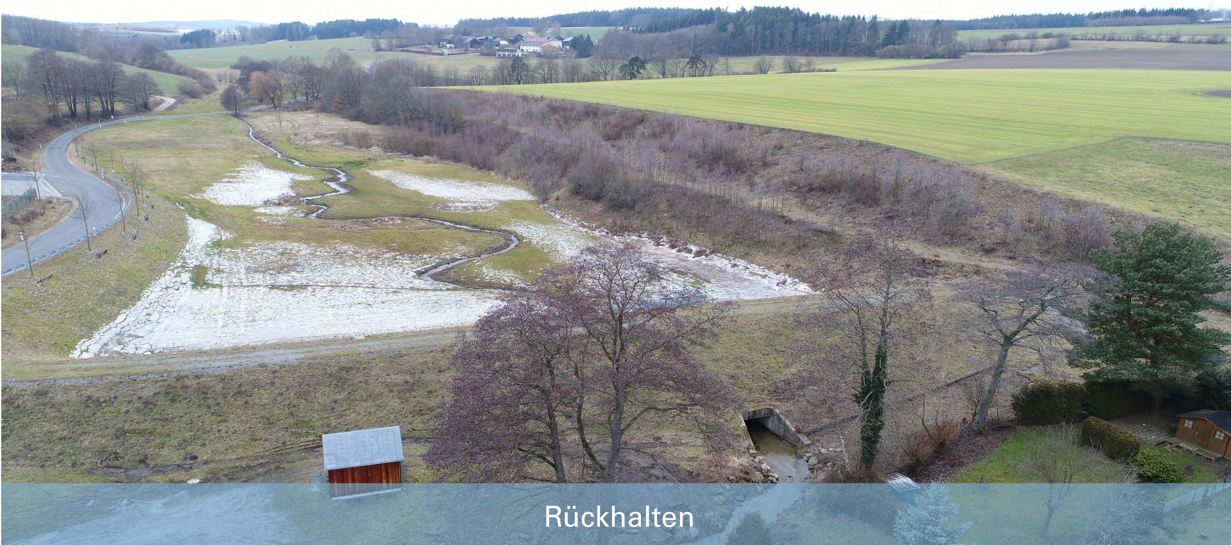
Auch in kleinen Einzugsgebieten müssen Hochwasserwellen gedämpft, zwischengespeichert und nach dem Hochwasserereignis wieder schadlos abgeführt werden. Am Krugelsbach bei Wunsiedel wurden Hochwasserrückhaltebecken (HRB) errichtet. Dieses Becken ist nur bei Hochwasser gefüllt. (Fotos WWA Hof)
