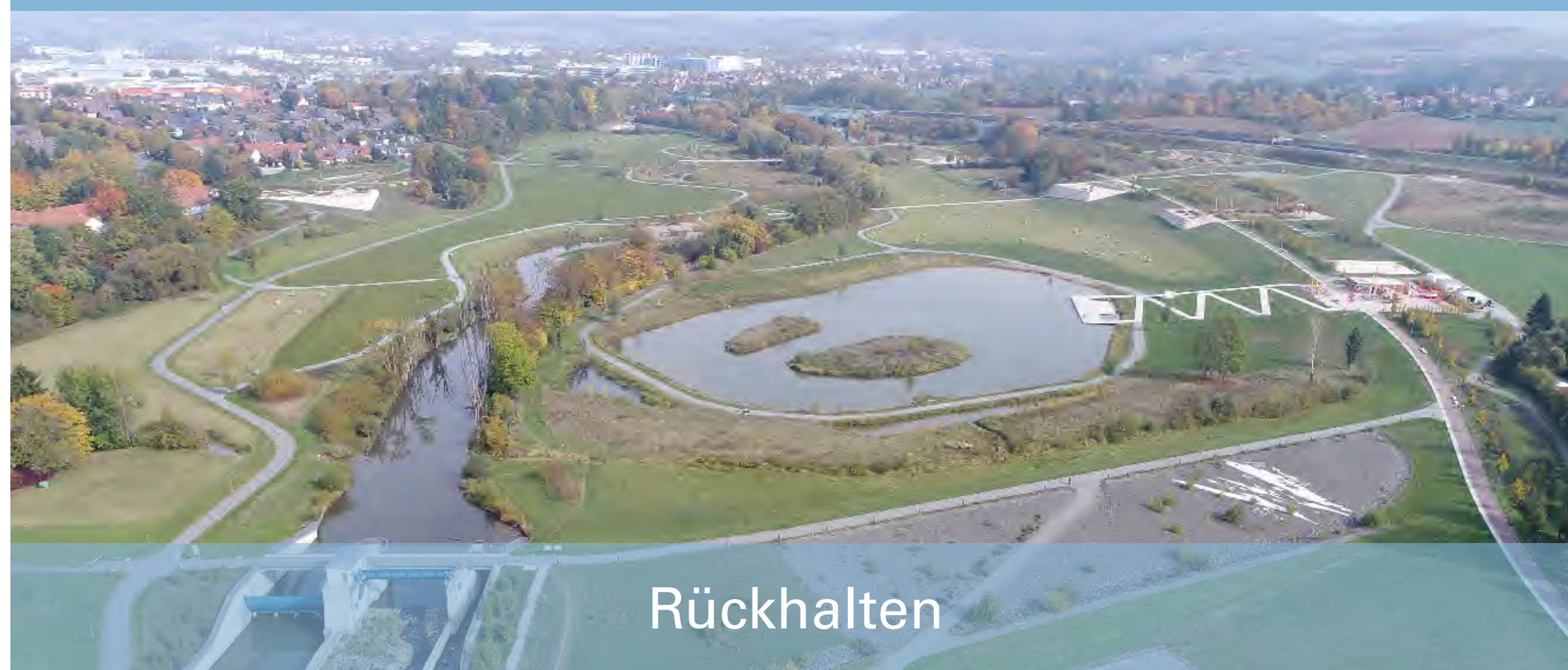
Hochwasserrückhaltebecken speichern Hochwasser vor Ortschaften. Beispielsweise das Becken am roten Main in der Wilhelminenaue in Bayreuth. (Foto WWA Hof)
