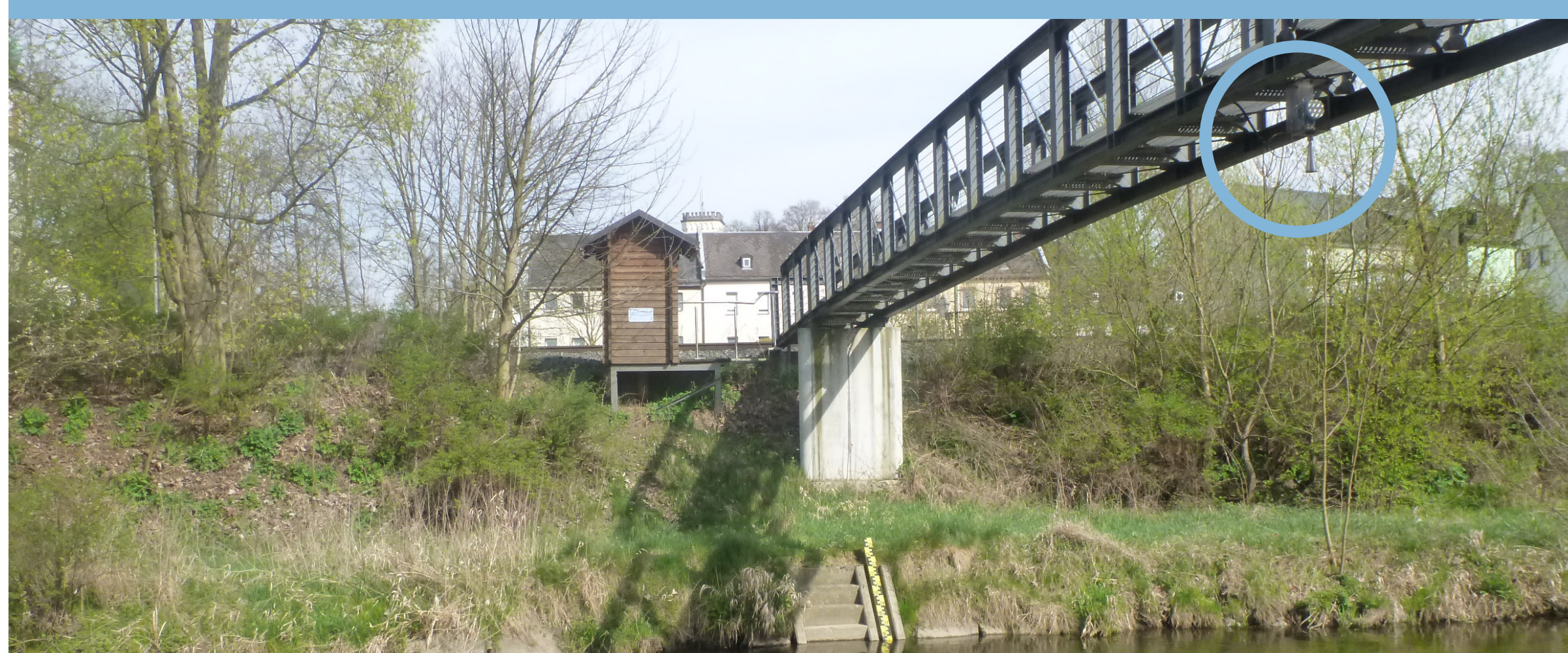
Die Pegelanlage in Oberkotzau an der Saale (Landkreis Hof). Unter dem Messsteg befindet sich ein Radarmessgerät (blauer Kreis), welches den Wasserstand misst. (Foto WWA Hof)
