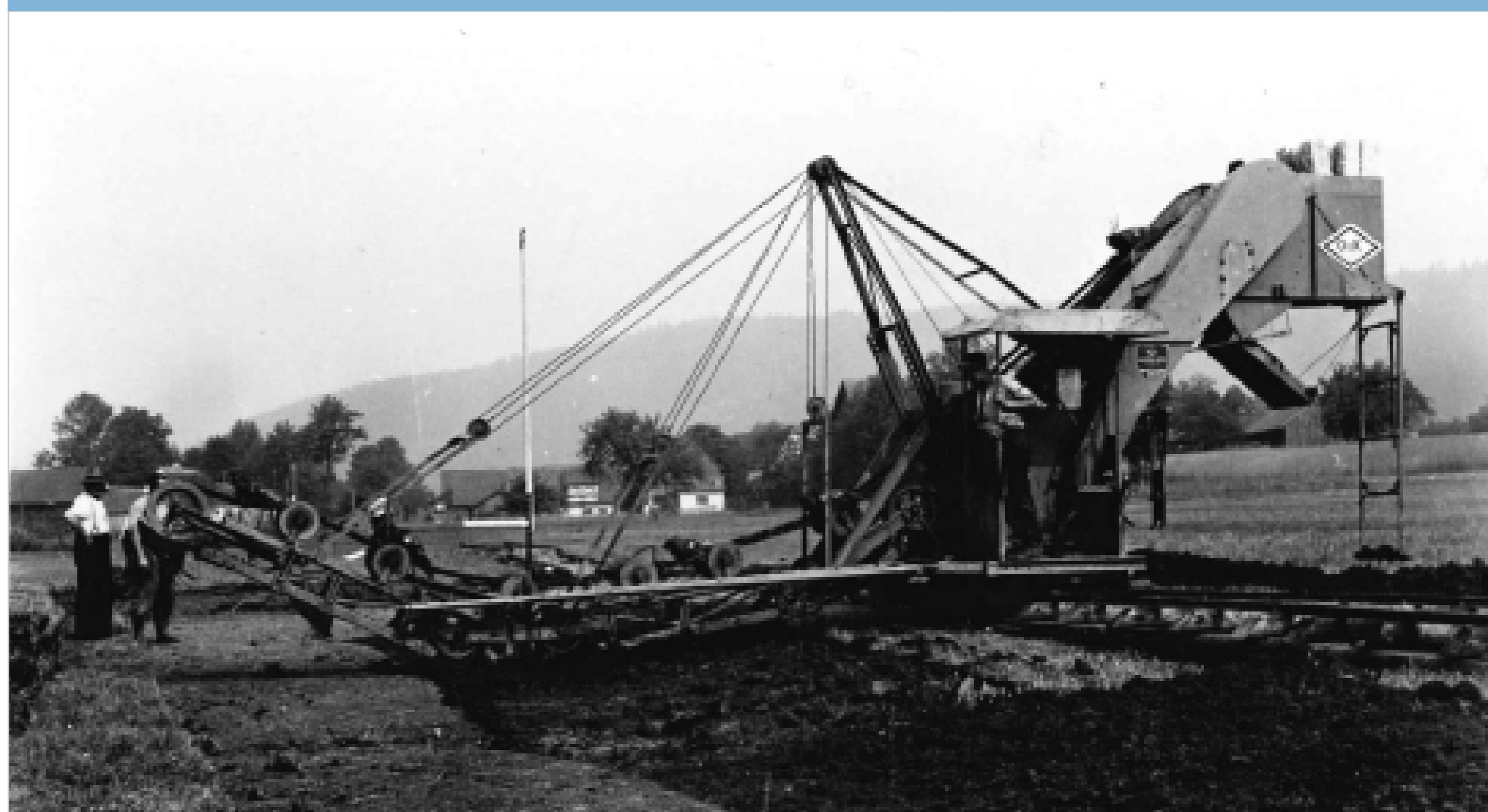
Mechanisierte Verlegung von Drainagerohren
