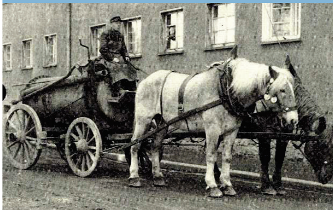
In der Hofer Region waren die sog. „Soripumper“ unterwegs, um die Entleerung der Gruben, mit von Pferden gezogenen Fässern, durchzuführen. Diese Fässer wurden in große Gruben vor den Toren der Städte entleert. (Foto WWA Hof)
