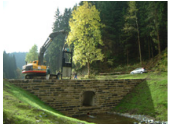
8. Schütz zur Hochwassersteuerung einbauen
