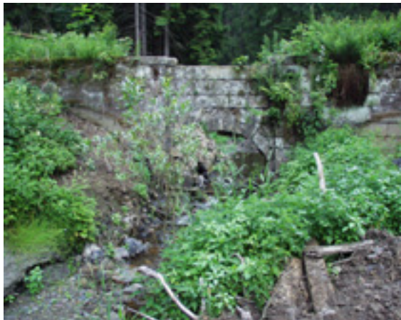
1. Ansicht vor Baubeginn
