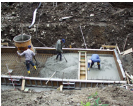
3. Bodenplatte Durchlass betonieren
