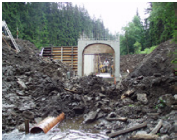
4. Durchlass und seitliche Flügelmauern errichten
