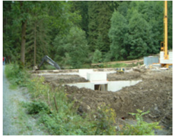
6. Bauwerk mit Erdreich hinterfüllen
