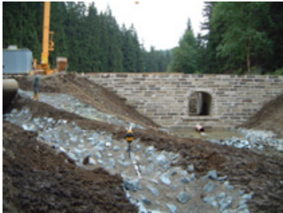
7. Tieraufstiegshilfe und Tosbecken anlegen
