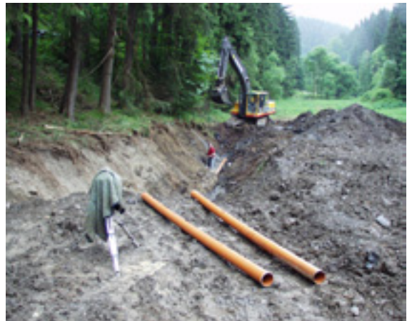
2. Abwasserleitung Gasthaus Bischofsmühle
