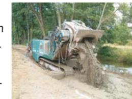
▲ Abdichtung des Untergrundes bis auf Felsstufe mit neuem Fräsverfahren und anschließendem Bau einer Hochwassermauer
