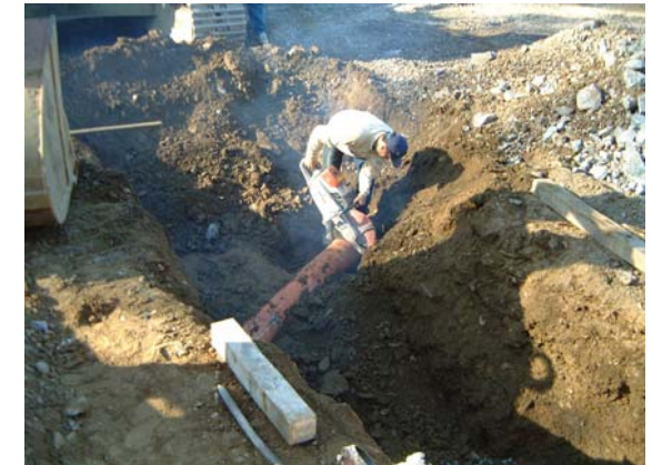
Durchtrennen einer seitlich ankommenden Leitung.
