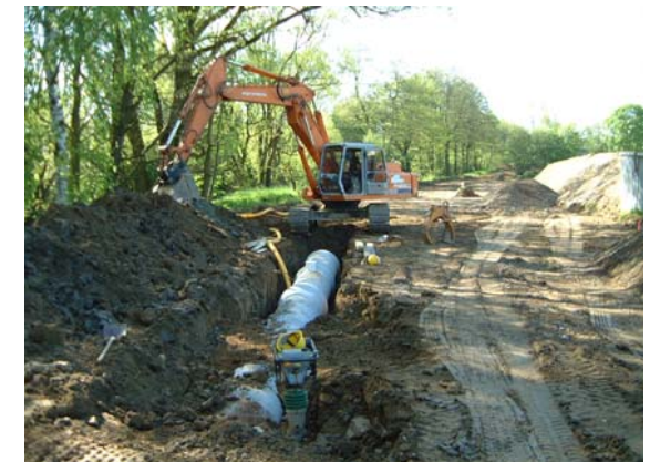
Verlegen und Einsanden der neuen Stahlbetonrohre.
