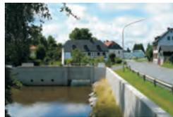
Ein System zur **Binnenentwässerung** und automatisch schließende Schützenanlagen sichern den Bereich des Mühlgrabens und Angers im Hochwasserfall.
