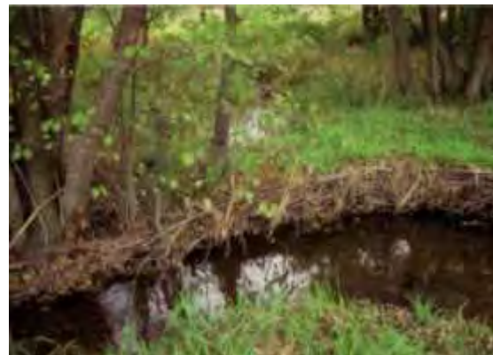
Ingenieurb biologische Ufersicherung (Flechtwerk)
