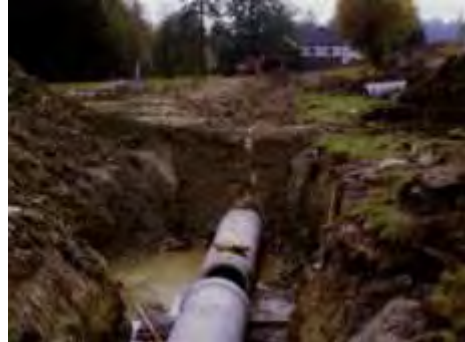
Zinnbachsammler im Bau
