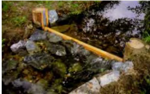
Naturnah gestaltetes Wehr am Zinnbach
