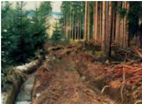
Erosionsgefahr; unbefestigter Holzabfuhrweg am Talrand
