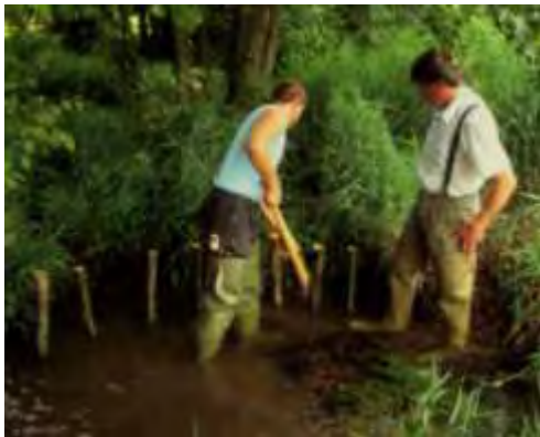
Sicherung eines Mäanderdurchbruches
