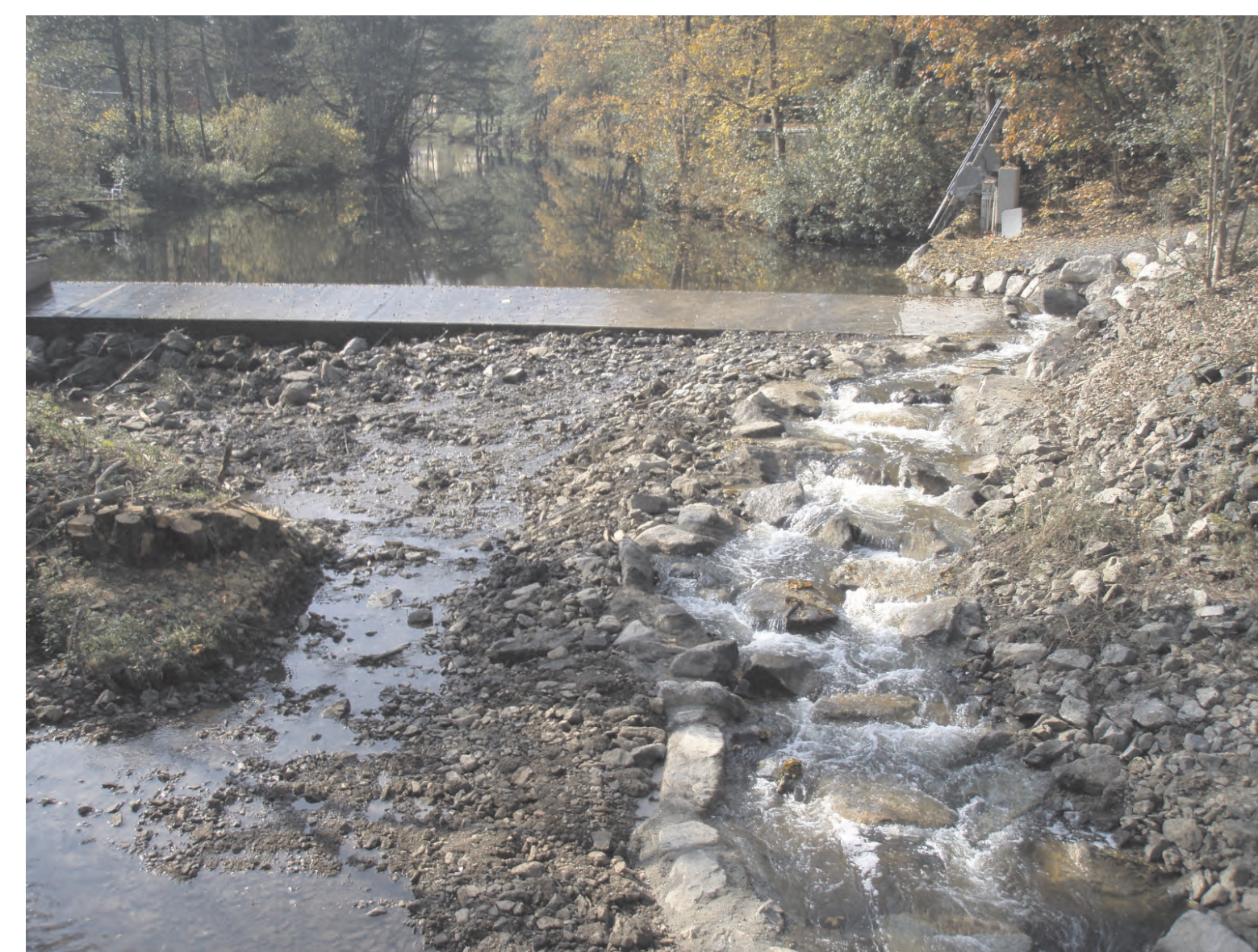
▲ Nach Fertigstellung im Herbst 2007
