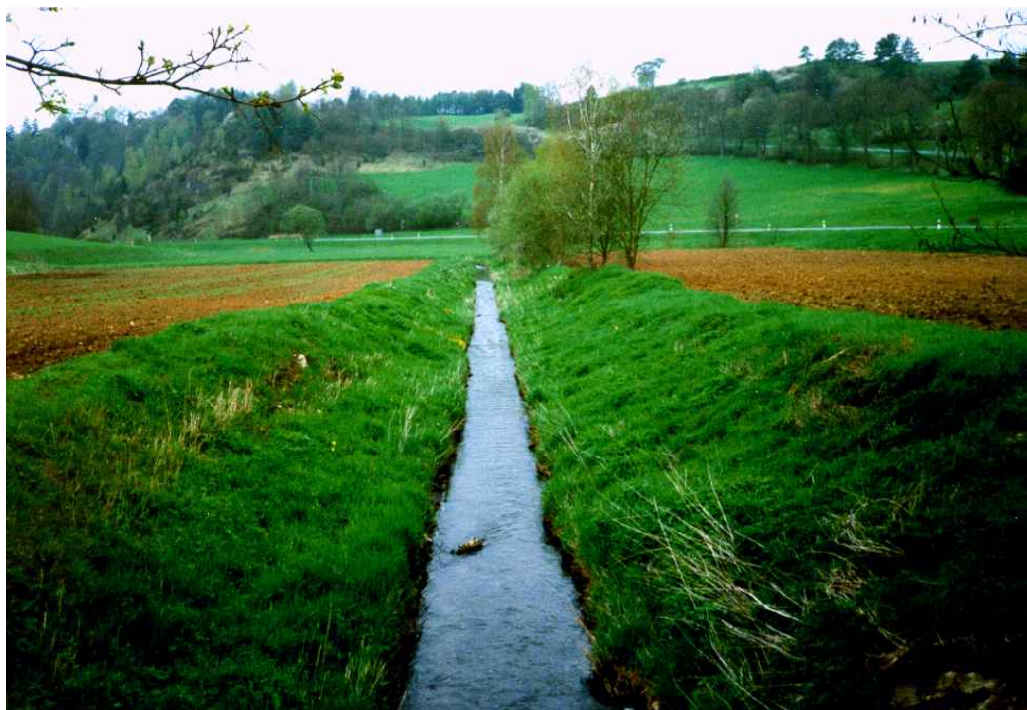
Der Ailsbach bei der Schweinsmühle vor dem Ausbau
