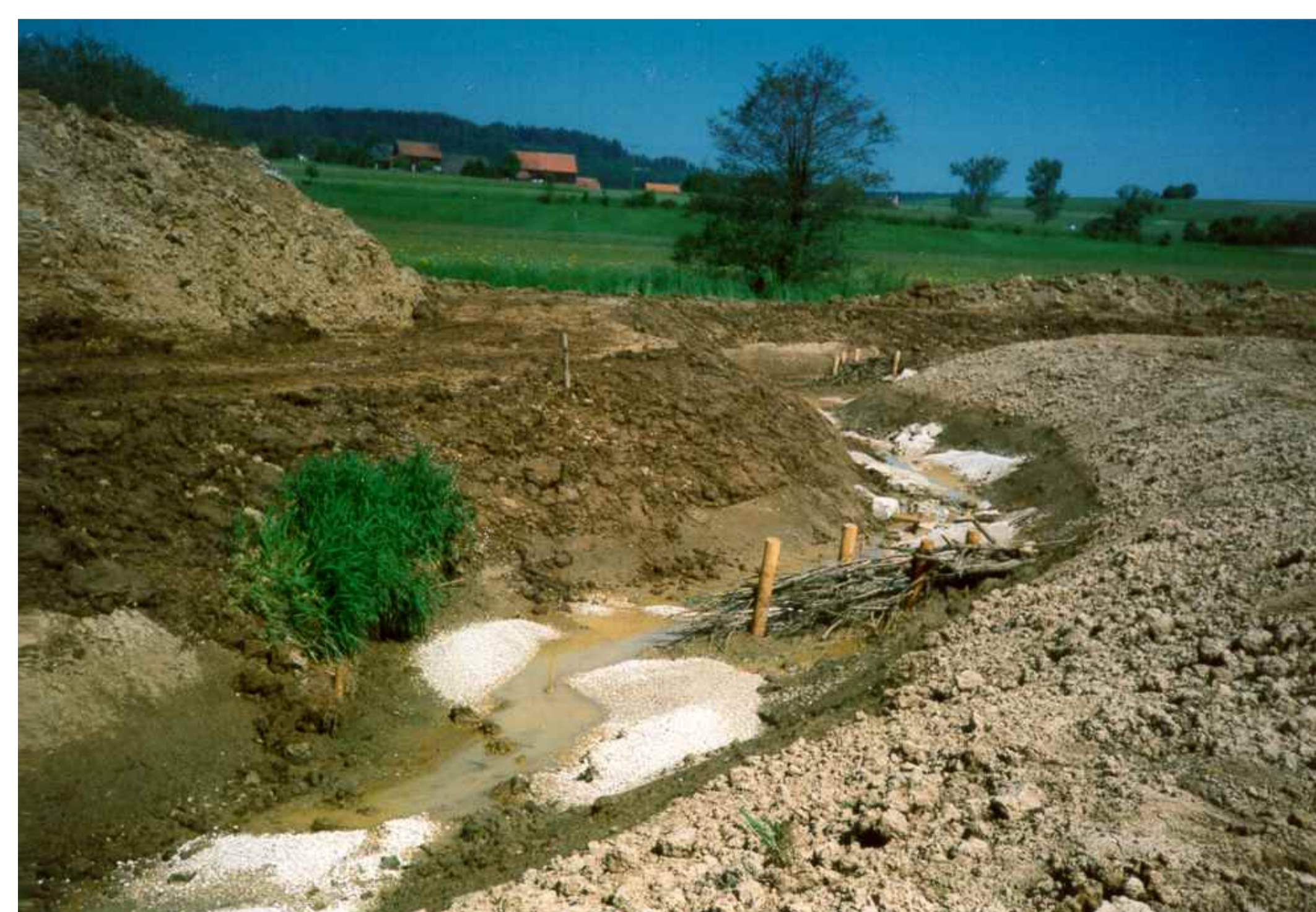
Zur Vermeidung größerer Abschwemmungen wurden die neuen Gewässerbereiche im Trockenem errichtet.
