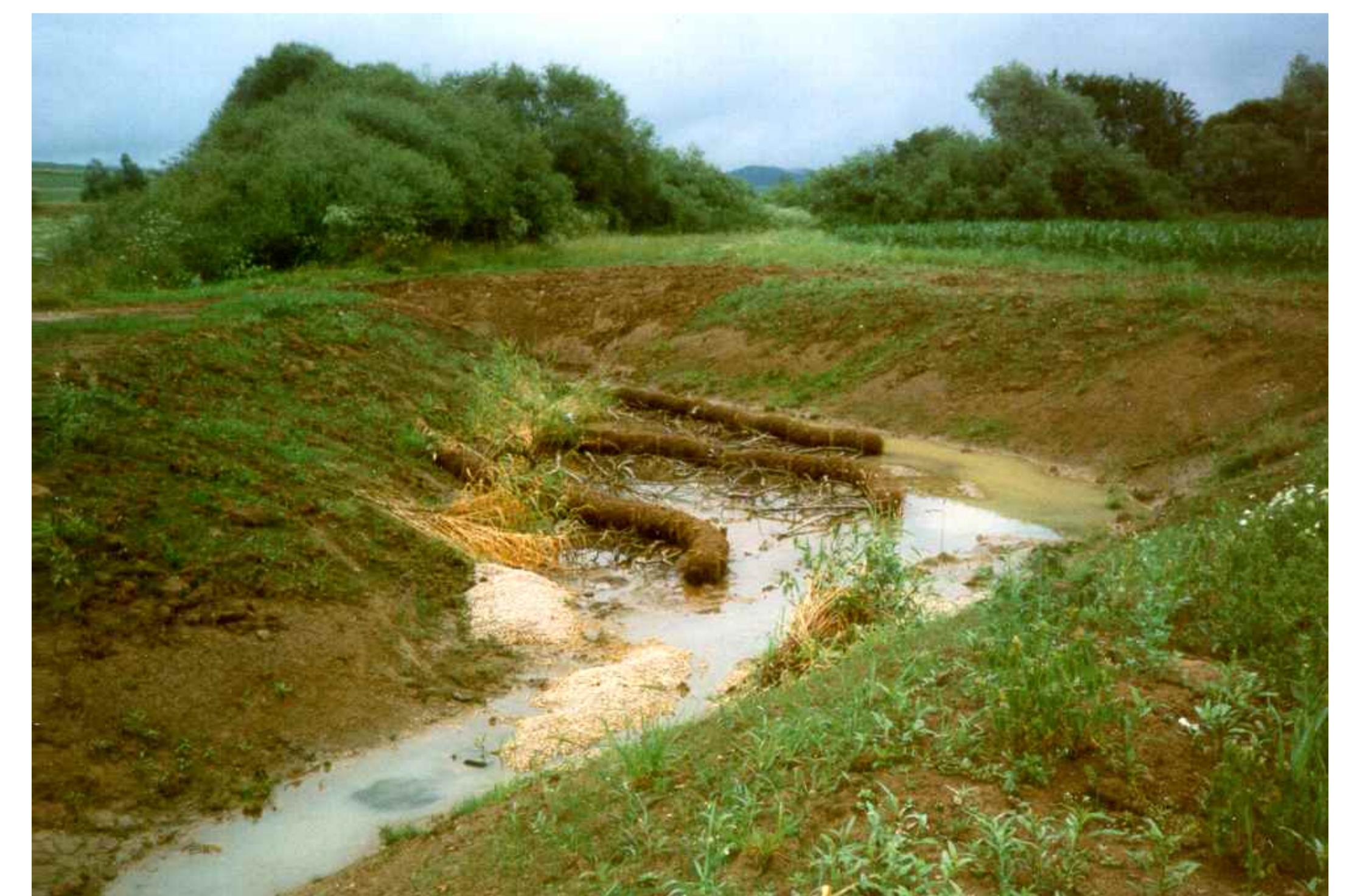
Damit sich Feinmaterial absetzen kann, wurden Buhnenfelder aus Vegetationsfaschinen angelegt.
