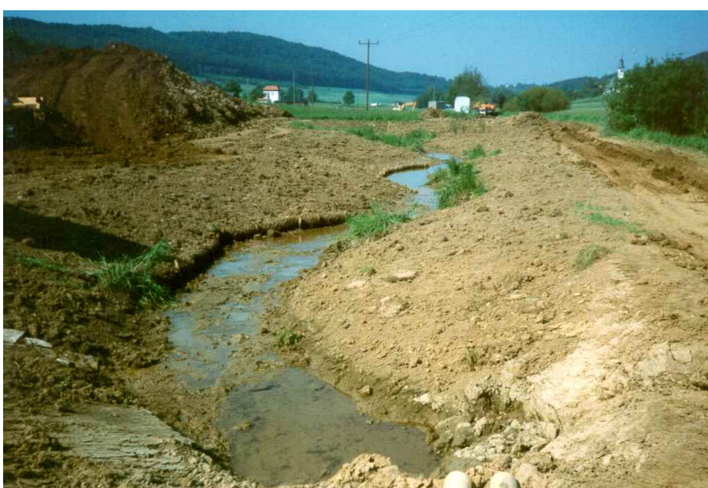
Das neu erstellte Gewässerbett des Ailsbaches
