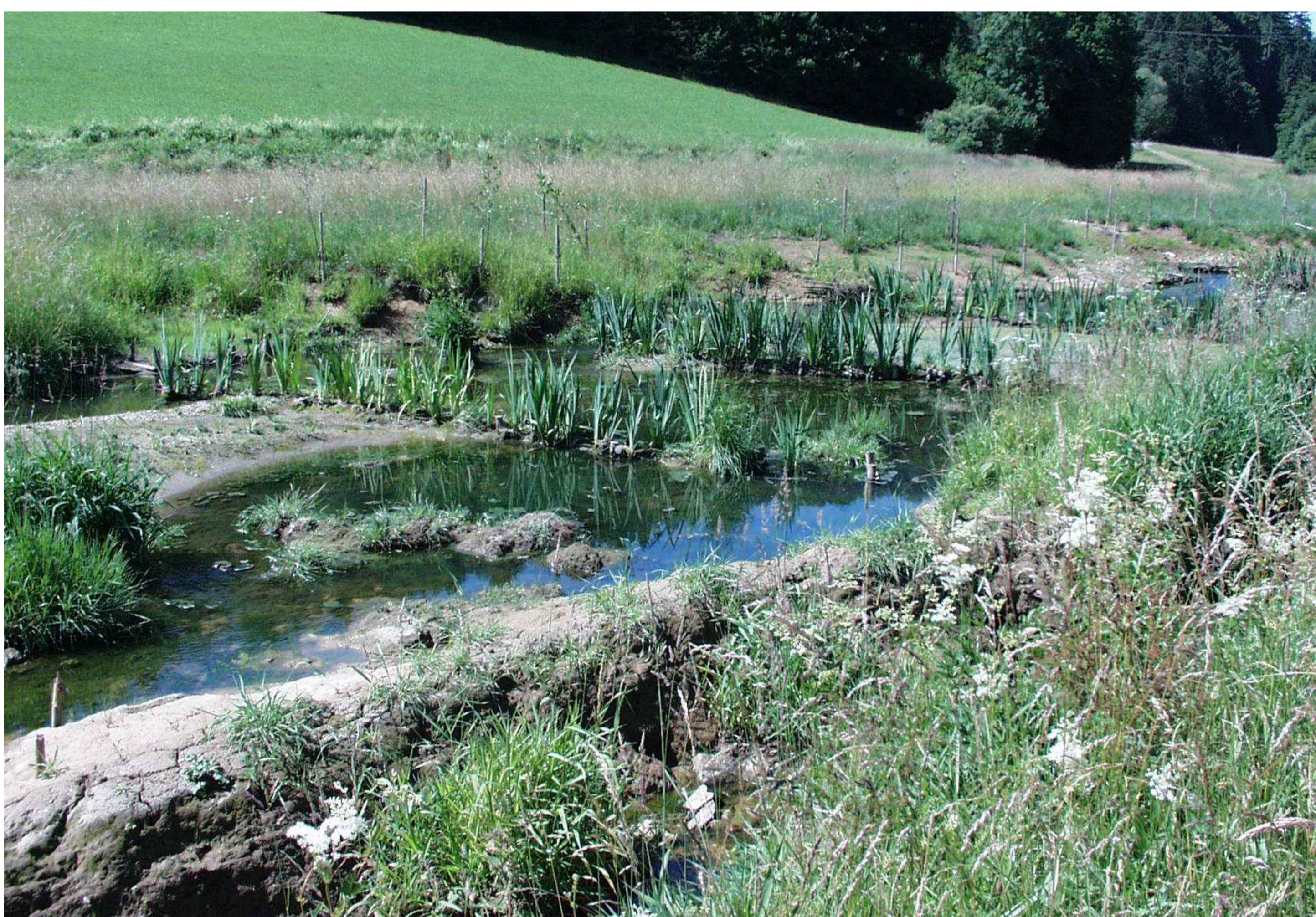
Mit gelber Sumpfschwertlilie bepflanzte Vegetationsfaschine als "Sedimentkamm"
