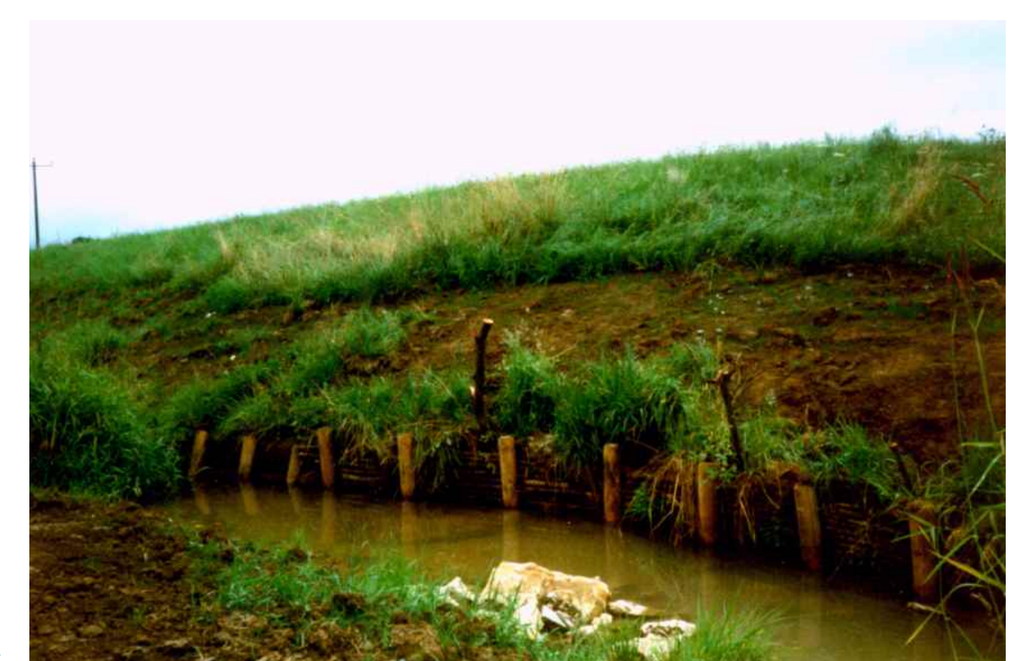
Ingenieurbiologische Ufersicherung mittels Flechtwerk, Faschinen und Weidensetzholzer
