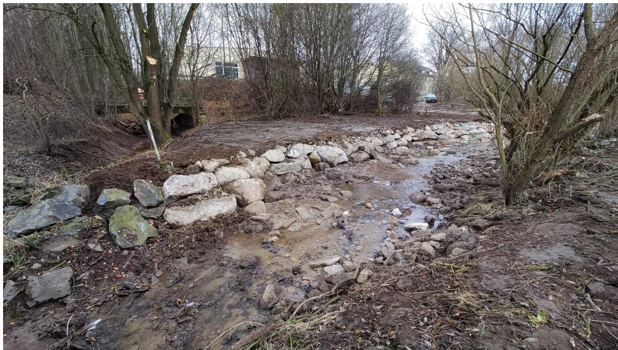
Abb. 1: gesicherte Uferbereiche an der Kössein (Brand – Fridau)
