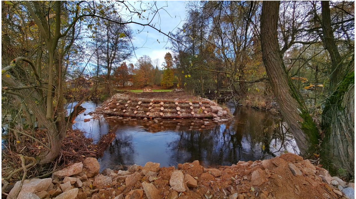
Abb. 3: gesicherte Uferbereiche an der Röslau bei Arzberg-Oschwitz (Krainierwand)
