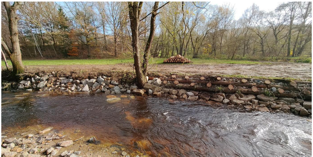
Abb. 4: gesicherte Uferbereiche an der Röslau bei Arzberg-Oschwitz (Steinverbau; links)
