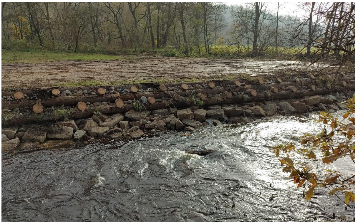
Abb. 5: gesicherte Uferbereiche an der Röslau bei Arzberg-Oschwitz (Kombination Stein-Holz)
