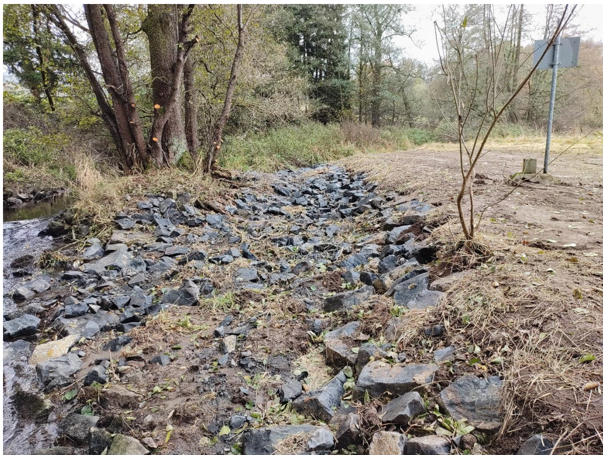
Abb. 2: gesicherte Uferbereiche an der Kössein (unterhalb Brand)
