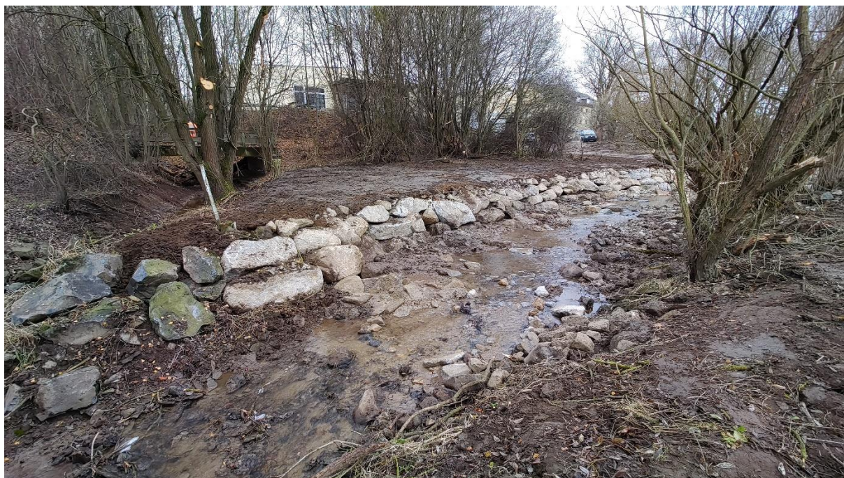
Obr. 1: Zpevněné břehové pásy na vodním toku Kössein (Brand - Fridau)
