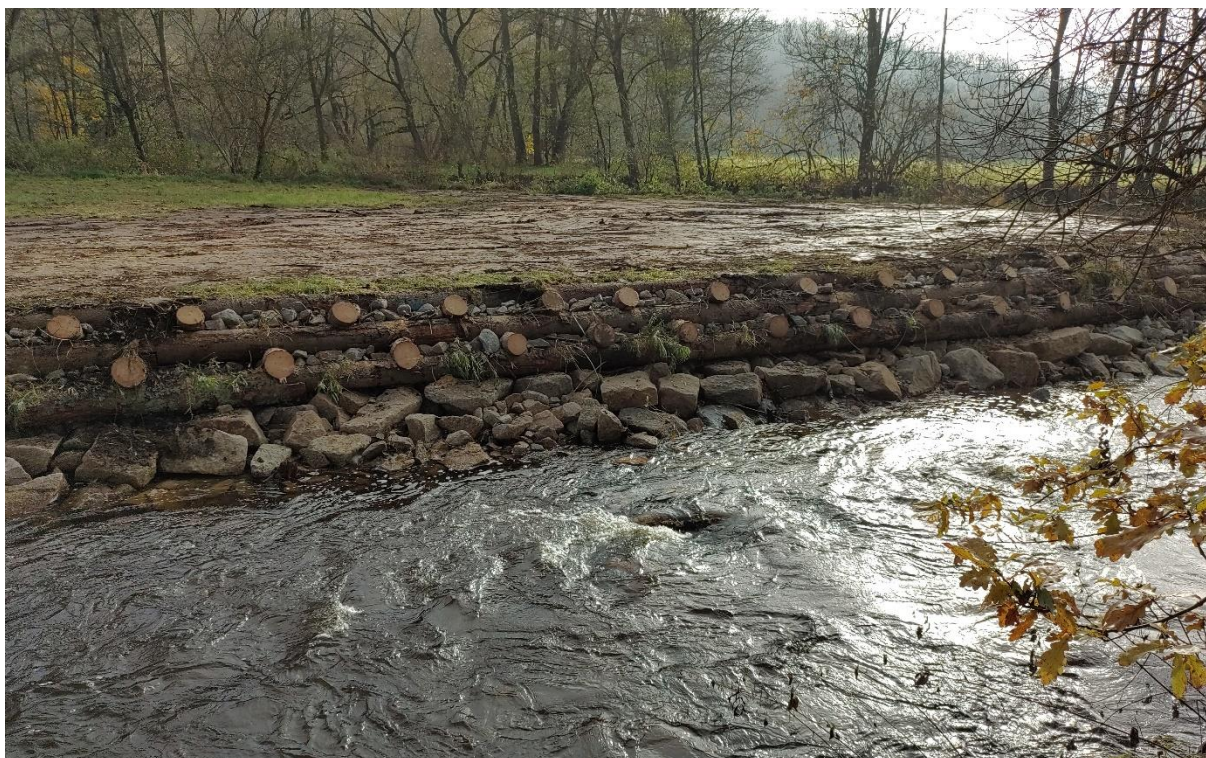
Obr. 5: Břehové opevnění na vodním toku Reslava u obce Arzberg-Oschwitz (kombinace kámen-dřevo)
